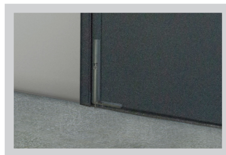
Pivot bas soudé dans le seuil (anti-vandalisme)
