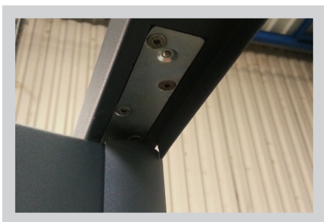
Pivot haut encastré dans le dormant (invisible)
